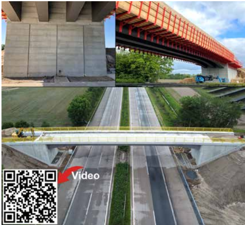
Abb.12: STRABAG Modulbrücke – Abb.: STRABAG
