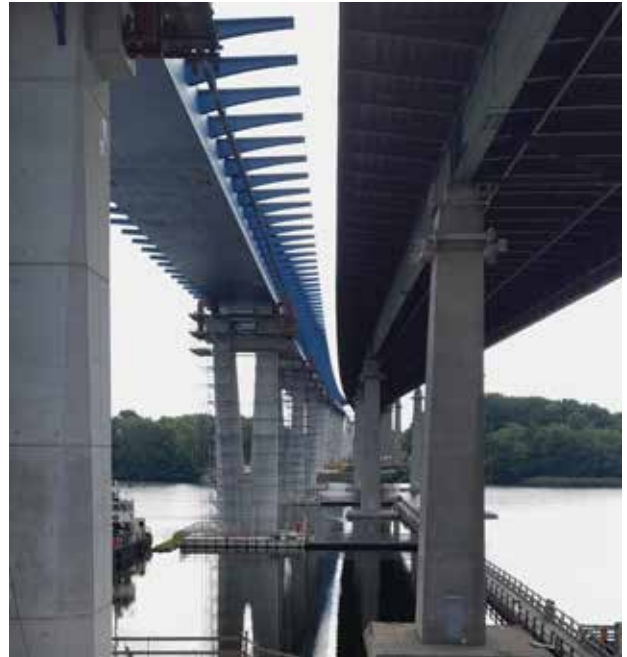
Abb. 8: Links – neue Brücke im Entstehen, rechts – alte Brücke
