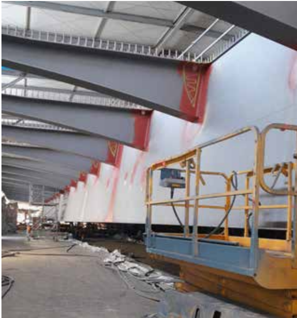
Abb. 7: In der Korrosionsschutzhalle nach dem Anschweißen der Kragarme
