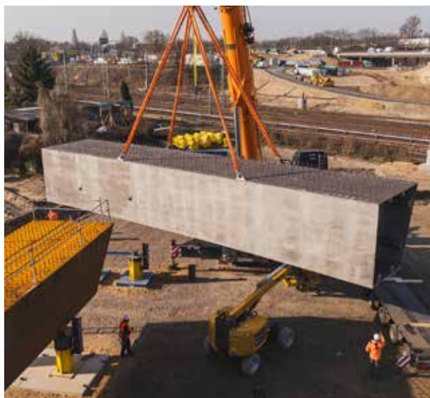
Anlieferung Stahlteile – Fotos: DEGES / Time:Code:Media
