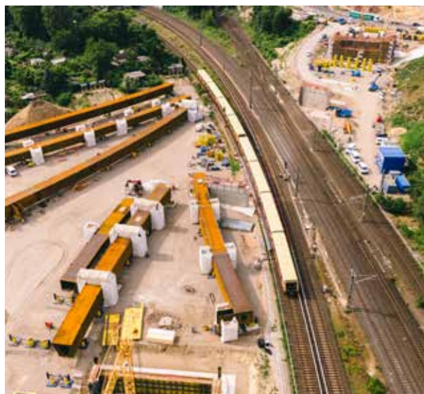
Verarbeitung Stahlteile – Fotos: DEGES / Time:Code:Media
