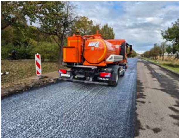
Aufbringen der Asphacal® TC Kalkmilch durch die MOT Müritzer Oberflächentechnik GmbH – Foto: MOT Müritzer Oberflächentechnik GmbH
