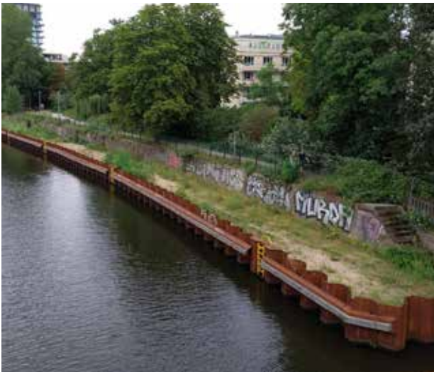
Abb. 3: Schleswiger Ufer (SOW linkes Ufer km 11,2) – Sofortsicherung
