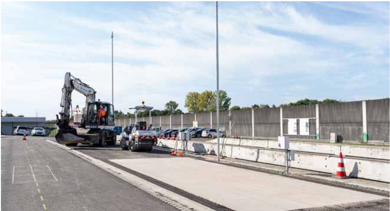
Abb. 3: Testfeld REVILÖ-Belag auf dem DuraBAST, Quelle: EUROVIA
