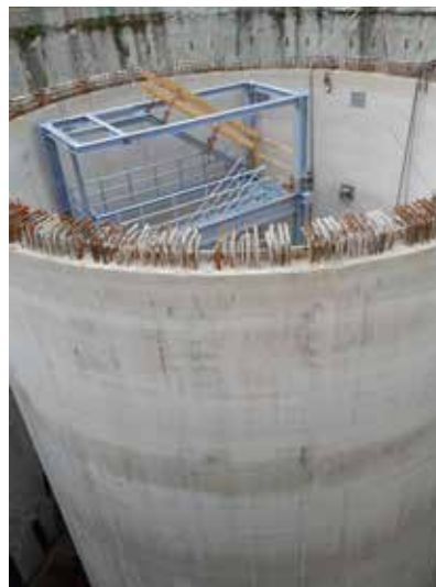
Abb. 2: Innerer Teil des Startschachts
