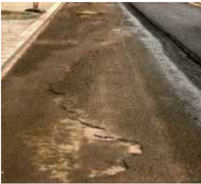
Bild 2 bis 4: Schlechter Zustand der Unterlage nach den Fräsarbeiten 1996
