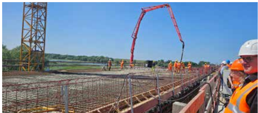
Baustellenführung A 14 – Elbebrücke bei Wittenberge
