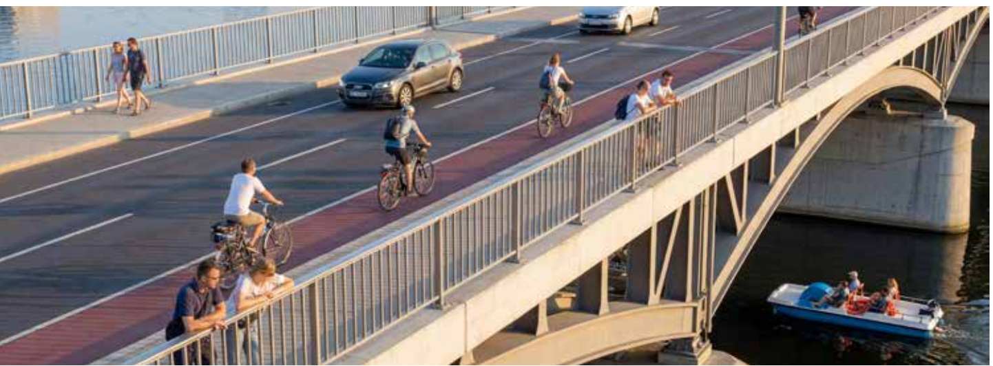
Abb. 17: Brücke im gut erhaltenen Zustand – Foto: Pollo.ai (KI-generiert)
