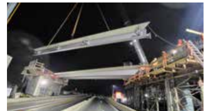
Abb. 11: Baulos 4 (KP 5) Foto Einbauen von Verbund-Fertigteil-Trägern bei Brücke ü. A 15
