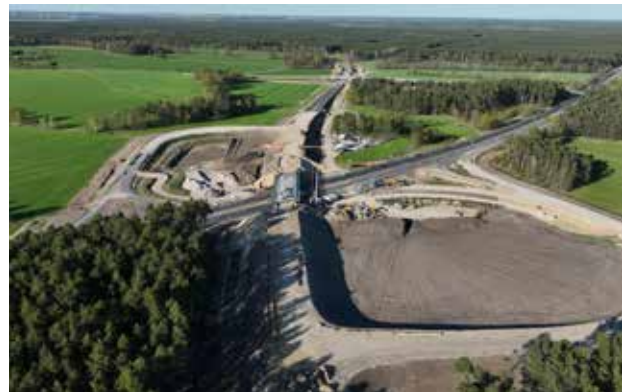
Abb. 8: Luftaufnahme Baulos 4 (KP 5) im Bau befindliche neue AS Cottbus Ost mit Blickrichtung Nordost
