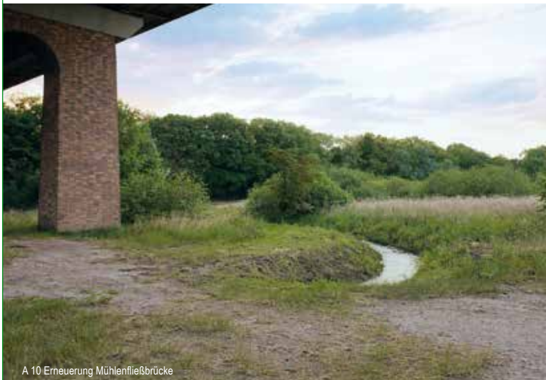
A 10 Erneuerung Mühlenfließbrücke
