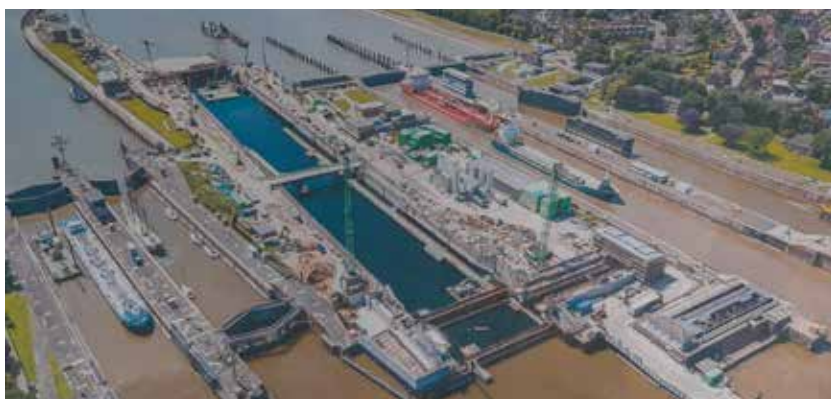
Abb. 11: Luftbild der Schleuse Brunsbüttel
