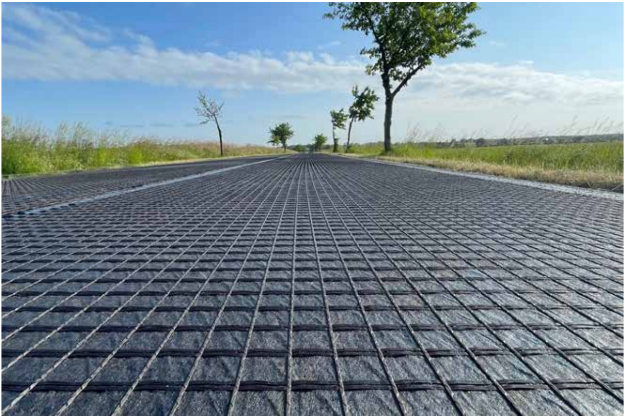
Bild 1: Der Einbau von Asphaltbewehrungen kann den CO 2 -Fußabdruck senken, indem die Haltbarkeit einer baulichen Erhaltungsmaßnahme verlängert wird – Fotos in diesem Beitrag: HUESKER Synthetic GmbH
