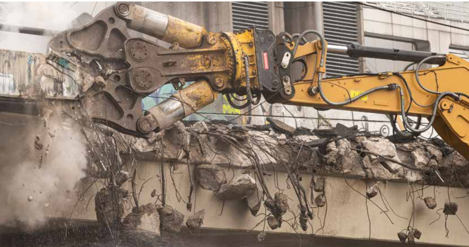
Abbruch – Foto: Autobahn GmbH
