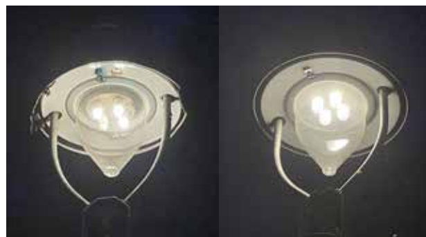
Abb. 6: Gasleuchte im Vergleich zur LED-Leuchte – Fotos: Jonathan Bratz
