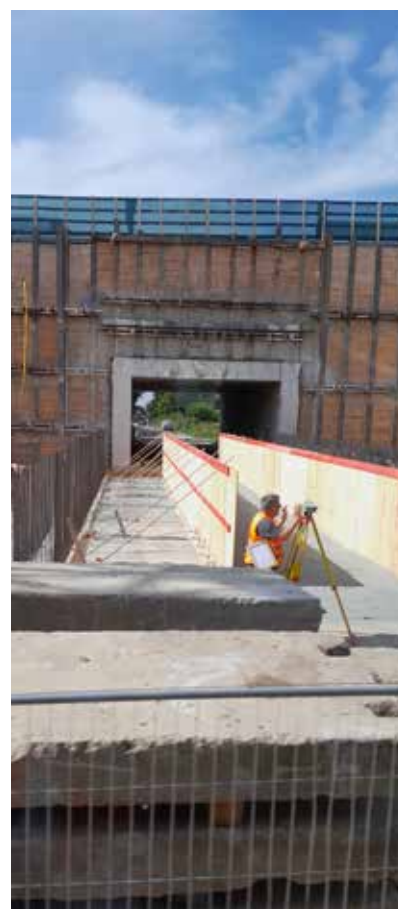
Abb. 6: Unterführung für den Radverkehr
