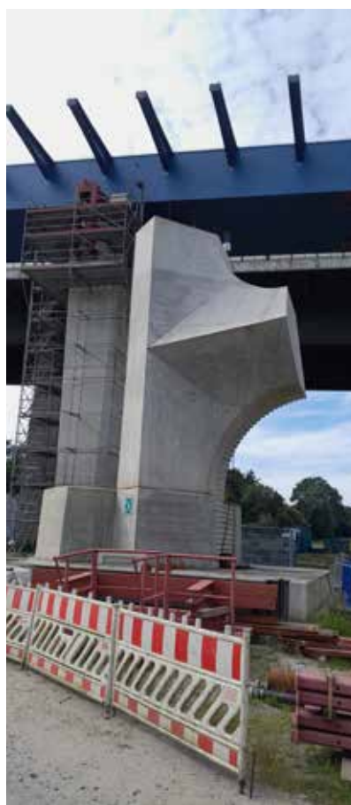
Abb. 5: Fertig betonierter Probekörper
