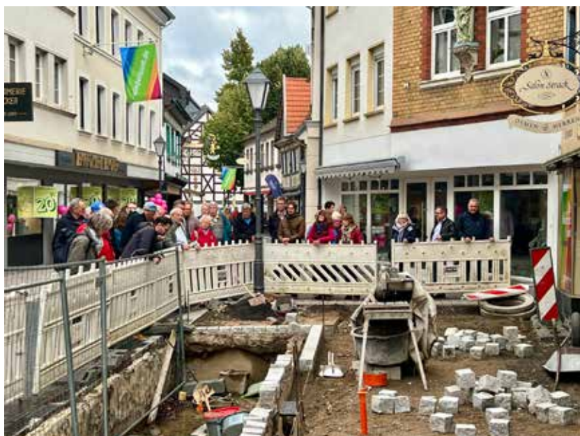
Kanalbau in der Altstadt von Ahrweiler
