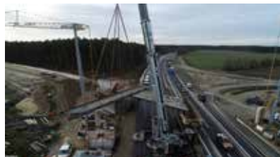
Abb. 10: Baulos 4 (KP 5) im Bau befindliche Brücke über die A 15 an neuer AS Cottbus Ost
