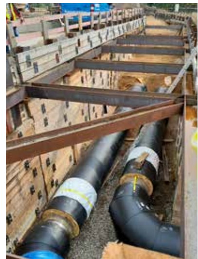
Abb. 3: Rohrgraben mit Vorlauf- und Rücklaufrohren
