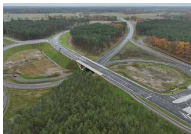
Abb. 6: Luftaufnahme Baulos 3 neuer Knotenpunkt B 168 / L 49 (KP 3)
