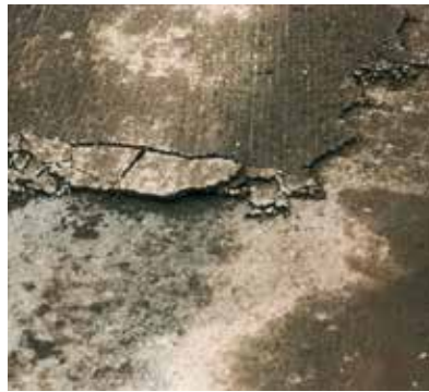
Bild 2 bis 4: Schlechter Zustand der Unterlage nach den Fräsarbeiten 1996
