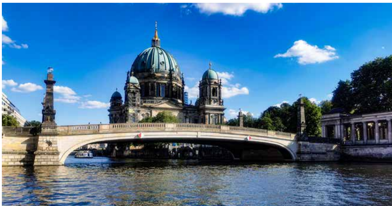
Abb. 3: Friedrichsbrücke Berlin – Foto: SenMVKU
