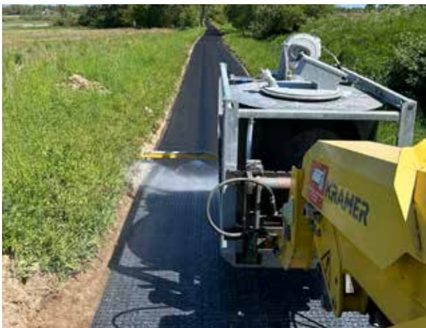
Der Asphacal-O-mat mit 1000-Liter-Tank im Einsatz bei der MOT Müritzer Oberflächentechnik GmbH – Foto: MOT Müritzer Oberflächentechnik GmbH
