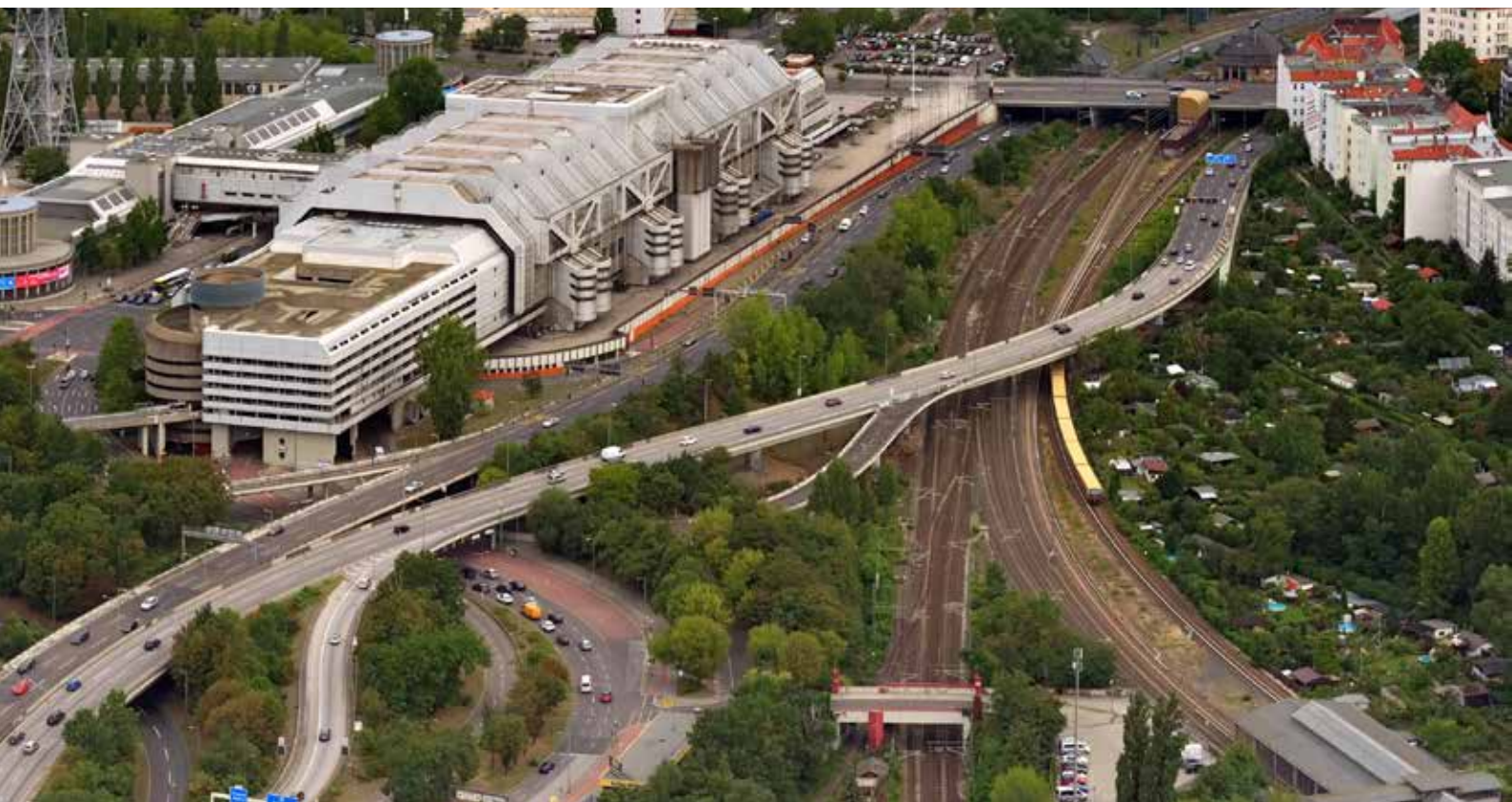
Altes Bestandsbauwerk – Foto: Hajo Dietz
