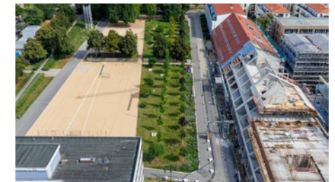
Blick vom Turm auf die durch Rechenzentrum und Sportplatz versiegelte Plantage – rechts das entstehende Kreativquartier. Foto: Peter-Michael Bauers 2024
